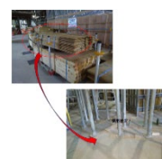
型枠支保工用敷板として廃材利用
