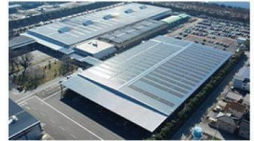
太田ドア工場物流棟に設置した太陽光発電設備
