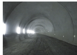
茂木トンネル 長崎県長崎市 | 2016年
