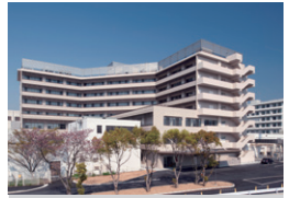
香川大学医学部附属病院南病棟 香川県木田郡 | 2014年
