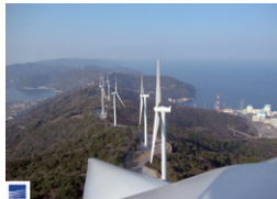
伊方風力発電 愛媛県西宇和郡 | 2011年
