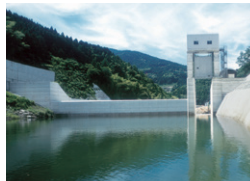
富郷ダム調整堰 愛媛県伊予三島市 | 2001年
