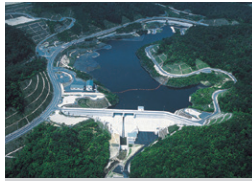
山田川ダム 広島県世羅町 / 2005年
