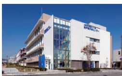
兵庫県立粒子線医療センター 附属神戸陽子線センター 兵庫県神戸市 / 2017年
