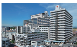
日赤和歌山医療センター新本館 和歌山県和歌山市 / 2012年
