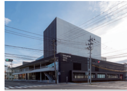
釜石市民ホール 岩手県釜石市 | 2017年
