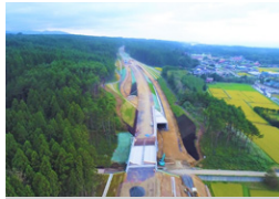
国道45号宿戸八木地区道路改良 岩手県九戸郡 | 2020年
