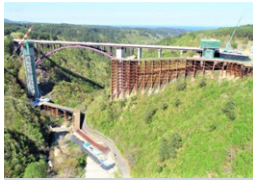
国道45号新思惟大橋下部工 岩手県下閉伊郡 | 2020年
