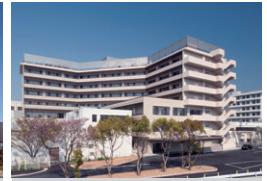
香川大学医学部附属病院南病棟 香川県木田郡 | 2014 年
