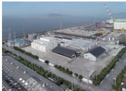
丸亀市浄化センター 香川県丸亀市 | 2023 年
