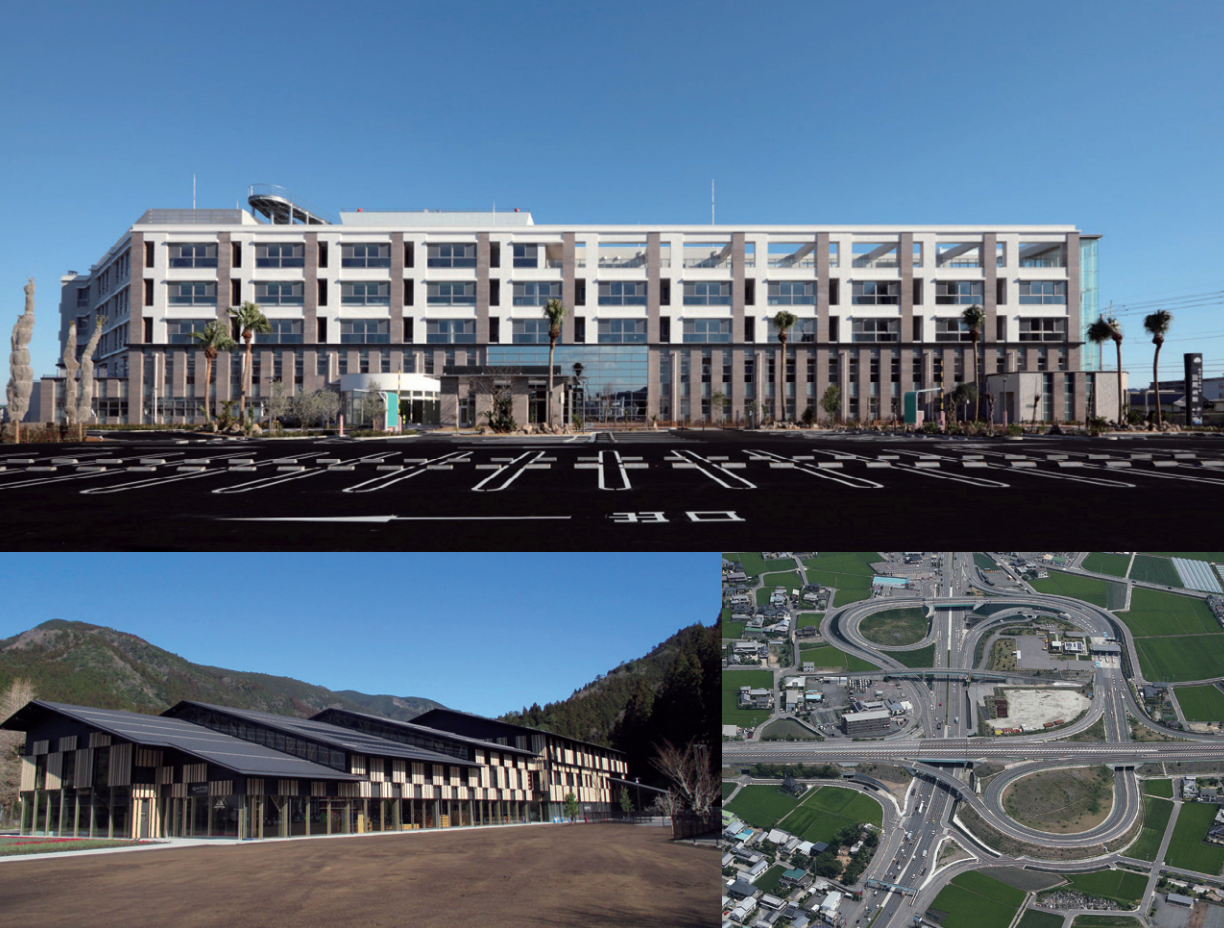
上：田岡病院（徳島県徳島市 | 2011 年）／左下：梶原町立図書館（高知県高岡郡 | 2018 年）／右下：徳島インターチェンジ（徳島県徳島市 | 2014 年）
