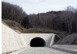
尾道松江自動車道川平トンネル 広島県庄原市／2012年
