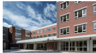
明治学院高等学校校舎改築 東京都港区 | 2022年
