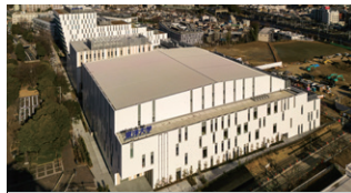
東洋大学赤羽台新校舎3期 東京都北区 | 2023年
