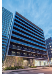
プライマル船橋 千葉県船橋市 | 2021年
