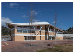
女川町温泉温浴施設 宮城県牡鹿郡 | 2015 年
