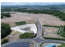
富谷市高屋敷西土地区画整理事業 宮城県富谷市 | 2024 年
