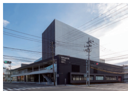
釜石市民ホール 岩手県釜石市 | 2017 年
