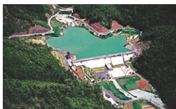
兵庫県三宝ダム建設 兵庫県春日町／1995年
