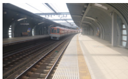
阪神本線鳴尾駅付近 連続立体交差(第2工区) 兵庫県西宮市／2018年
