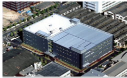
島津製作所新W3号館 京都府京都市／2006年
