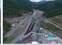
国道45号両石地区道路 岩手県釜石市／2017年
