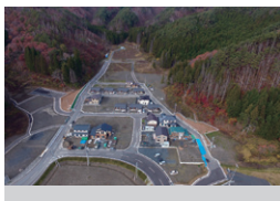
釜石市根浜地区他 復興整備事業用造成 岩手県釜石市／2016年
