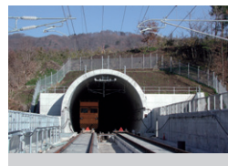
東北新幹線金田一トンネル南工区 岩手県二戸市／2001年
