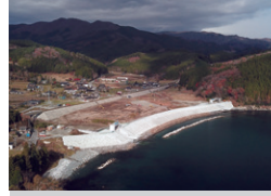
下南嶺地先海岸災害復旧 岩手県大船渡市／2017年
