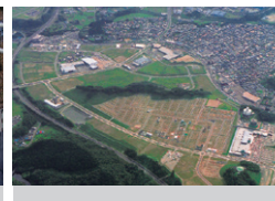
富谷町上桜木土地区画整理事業 宮城県富谷市／2004年
