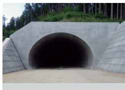
国道45号山田第1トンネル 岩手県下閉伊郡／2016年
