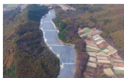
クリーンエネルギー清里の杜 太陽光発電所 山梨県北杜市 | 2015 年
