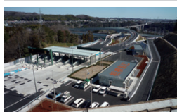
関東地整 さがみ縦貫相模原 IC 改良 神奈川県相模原市 | 2015 年
