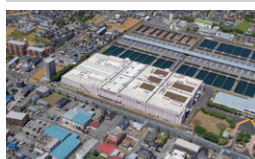
都水道局 朝霞浄水場高度浄水施設二期 埼玉県朝霞市 | 2014 年
