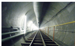
都下水道局中野一丁目、 中央二丁目枝線（竣工） 東京都中野区 | 2010 年
