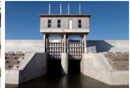
揖斐川城南排水機随管改築工事 三重県桑名市 | 2014年
