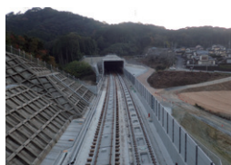
鉄運機構九幹西九州武雄トンネル 佐賀県武雄市 | 2019 年
