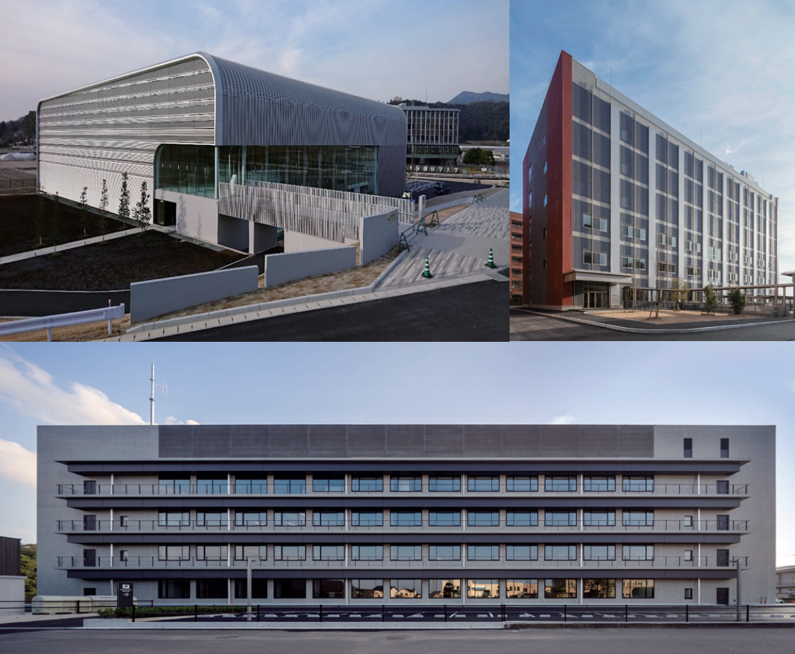
上左：熊本保健科学大学（熊本県熊本市 | 2018）／上右：久留米大学基礎3号館病院北（福岡県福岡市 | 2020年）／下：宇佐市新庁舎（大分県宇佐市 | 2019年）
