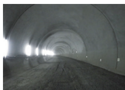
茂木トンネル 長崎県長崎市 | 2016 年
