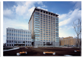
栃木県庁舎行政棟 栃木県宇都宮市 | 2007 年
