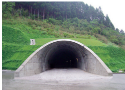
笹ヶ峰トンネル 愛媛県四国中央市／2005 年
