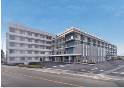
大洲記念病院 愛媛県大洲市／2016 年
