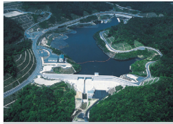
山田川ダム 広島県世羅町／2005年
