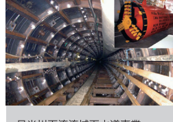
日光川下流域下水道事業 管きょ布設工事 愛知県海部郡／2007年
