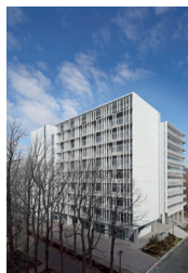
東海大湘南校舎19号館 平塚市 / 2016 年
