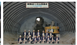
関東地整 中部横断醍醐山トンネル 2 山梨県南巨摩郡 | 2014 年
