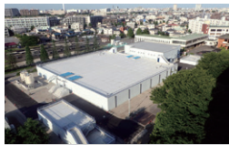
川崎市平間配水所調整池更新 神奈川県川崎市 | 2016 年
