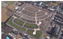
旭化成不動産レジデンス 袖ヶ浦宅地造成 千葉県袖ヶ浦市 | 2013 年
