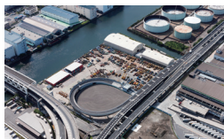
首都高生麦入口付替道路 神奈川県横浜市 | 2012 年
