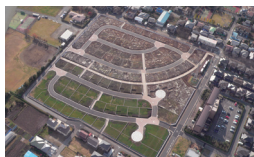
旭化成不動産レジデンス 袖ヶ浦宅地造成 千葉県袖ヶ浦市 | 2013 年
