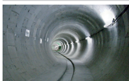
都下水道局 北区赤羽台三丁目付近再構築 東京都北区 | 2014 年
