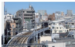
京急蒲田駅付近連立 8 工区 東京都大田区 | 2016 年
