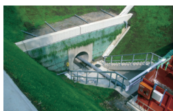
関東地整さがみ縦貫葉山島 排水トンネル 神奈川県相模原市 | 2014 年
