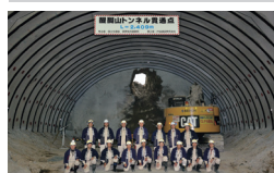
関東地整 中部横断醍醐山トンネル 2 山梨県南巨摩郡 | 2014 年
