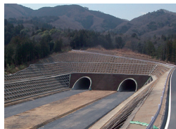
北関東道岩瀬トンネル東 茨城県桜川市／2007年
