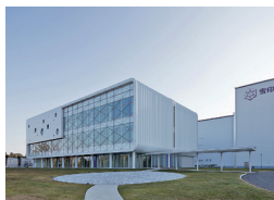
雪印阿見乳製品統合工場 茨城県稲敷郡阿見町／2016年
