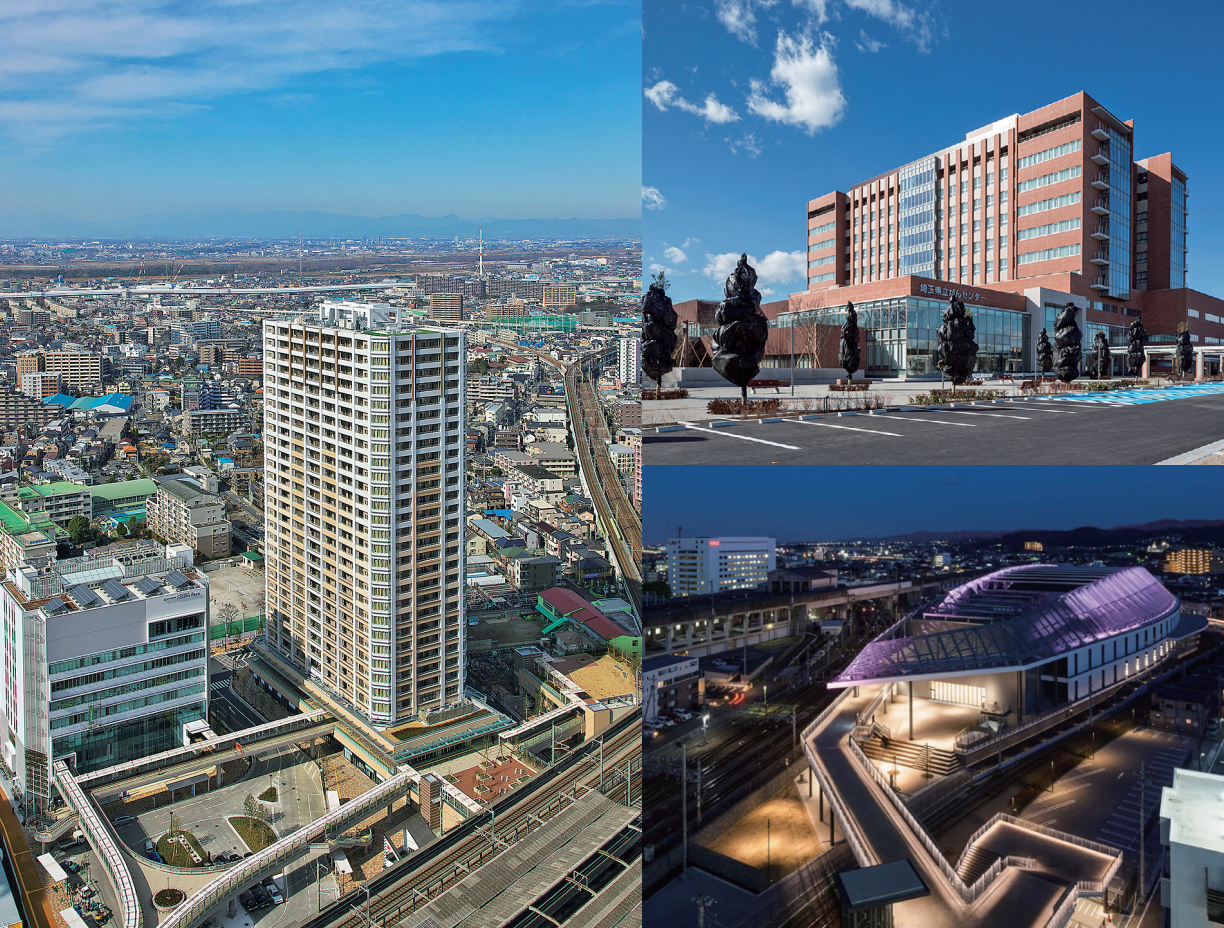
左：武蔵浦和駅第一街区再開発（埼玉県さいたま市 | 2013 年）／右上：埼玉県立がんセンター（埼玉県北足立郡 | 2013 年）／右下：高崎アリーナ（群馬県高崎市 | 2017 年）
