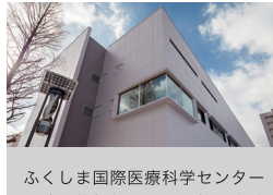
ふくしま国際医療科学センター 環境動態解析センター棟・先端 臨床研究センター・受施設棟 福島県福島市／2016年
